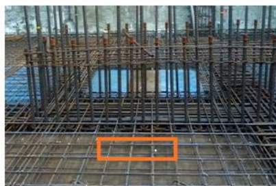
汽車充電未預留管道間
